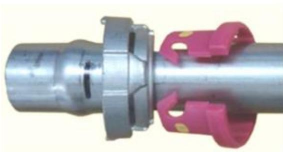
⑦拡管を実施後、直ぐに管へFIロックリングを装着する (FIロックリング忘れ対策)
