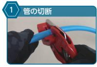
塩ビカッターで管に直角に 切断してください
